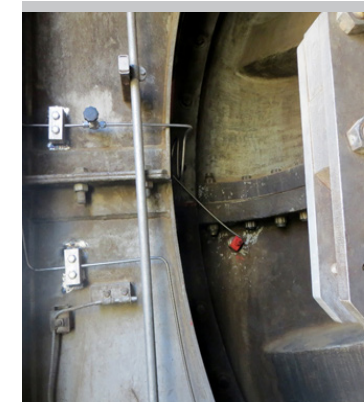
نصب سنسورها در ورودی کمپرسور
